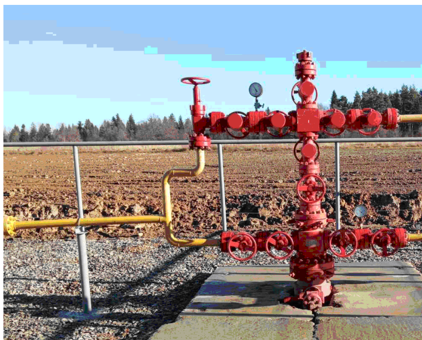
Рисунок 1.4 – Варіант облаштування буферного фланця ФА гайкою швидкого з'єднання
