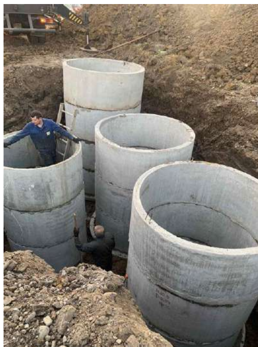
Спорудження вузла теплообмінників розсільного контура
