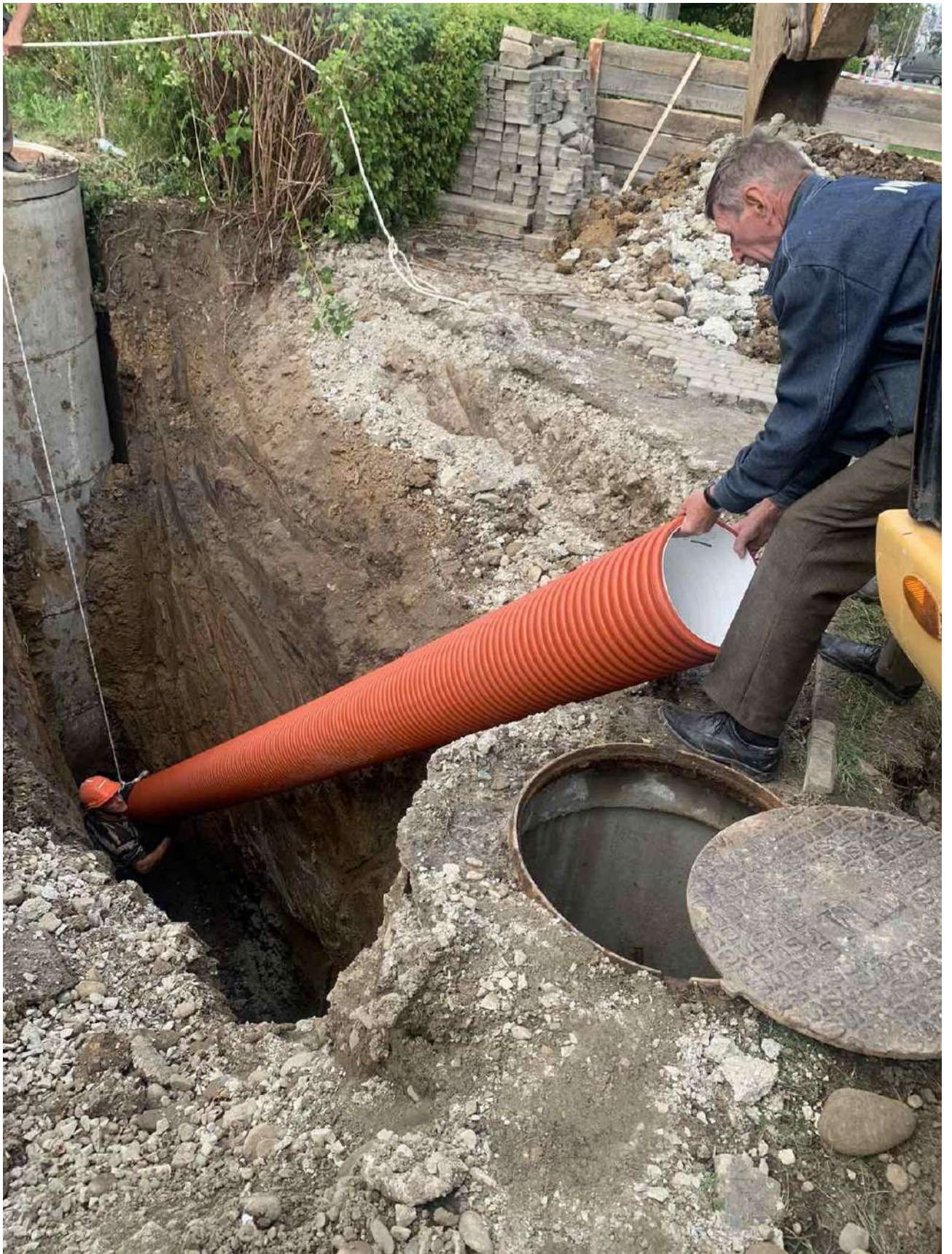
Встановлення труби подачі каналізаційних стоків до насосної станції розсільного контура
