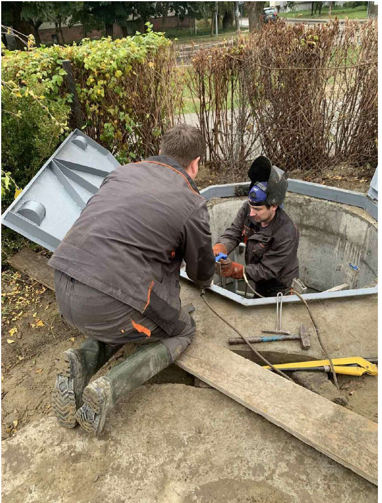
Монтаж насосної станції розсільного контура
