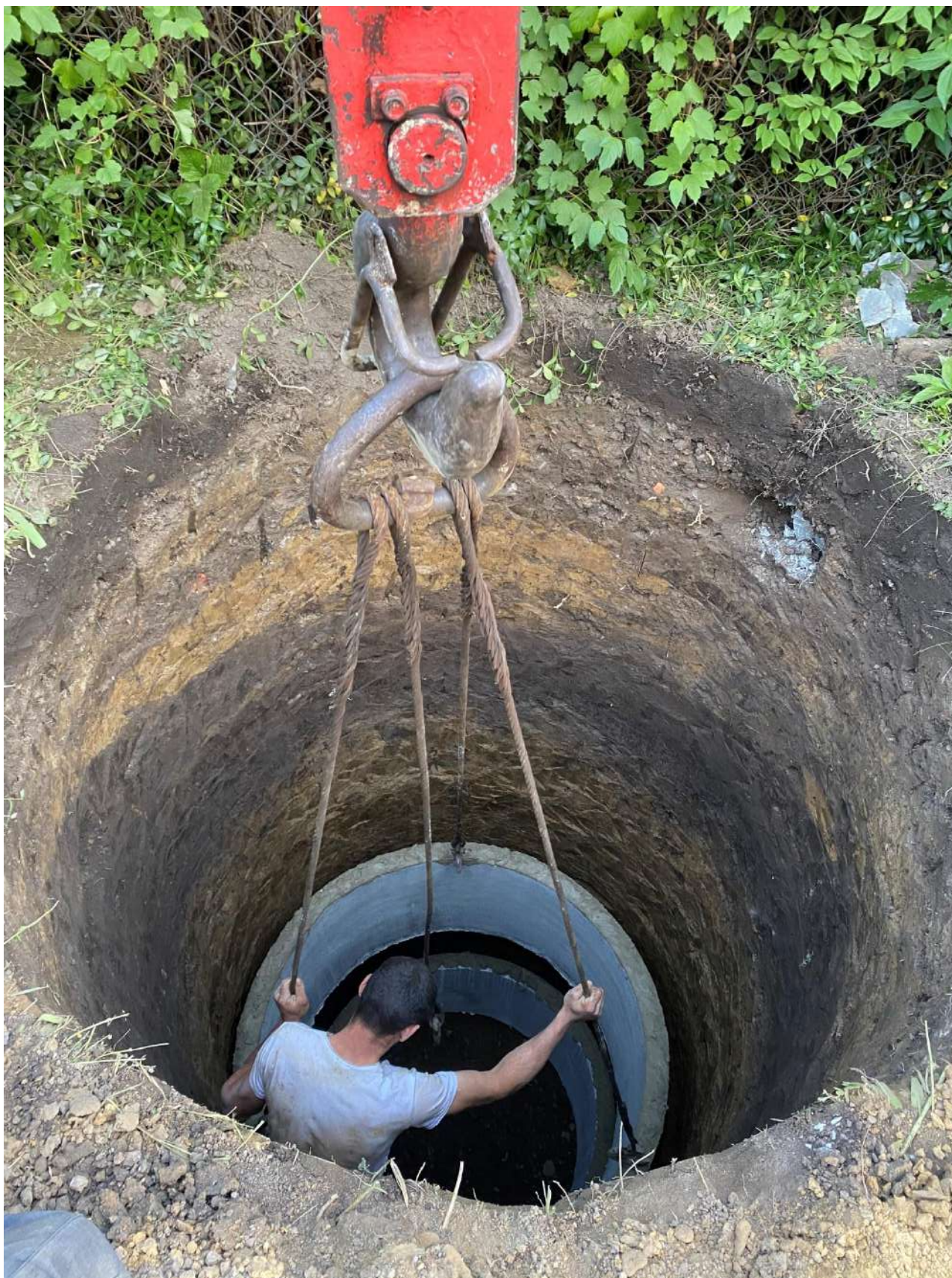
Монтаж колодязя для розміщення насосної станції розсільного контура
