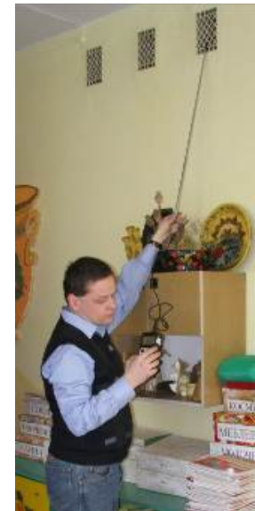
Перевірка роботи системи вентиляції
