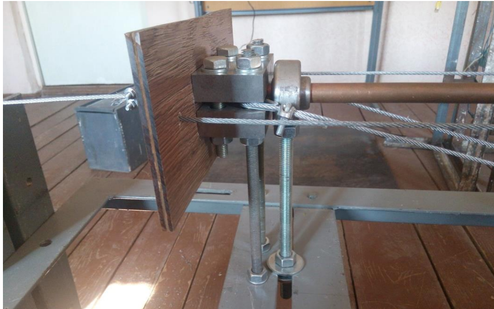
Рисунок 2.4 – Загальний вигляд опорного вузла
