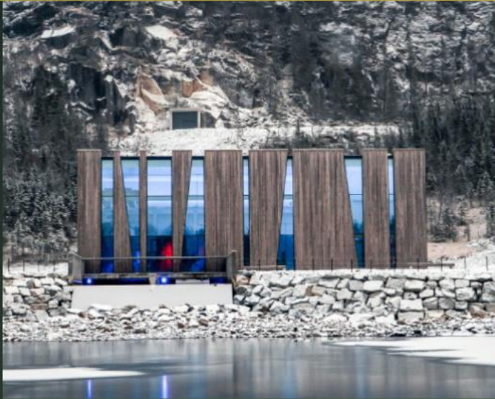
Норвезька гідроелектростанція Øvre Forsland
