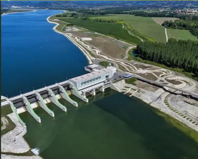
Гідроелектростанція Vrežice, берег річки Сава, Словенія
