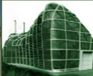
Біогазова установка "БІО-10" УкрФгроБіоГаз
