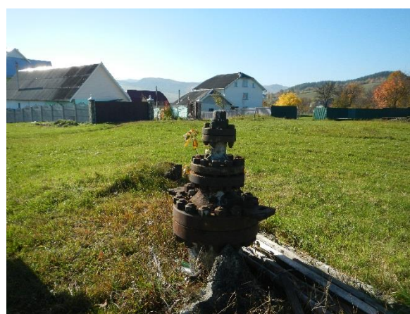
Рисунок 3.14 – Облаштування свердловин, що виведені з експлуатації а – законсервована свердловина з встановленою цементною тумбою; б – не законсервована свердловина, що виведена з експлуатації
