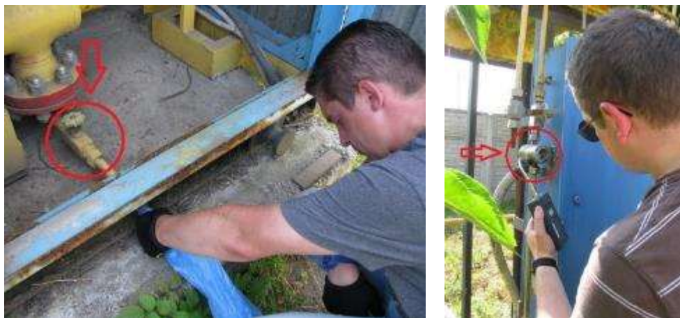
Рисунок 5.5 - Виявлення нетехнологічного витoku природного газу на елементах обладнання АГНКС: а) дренаж замірного вузла; б) індикаторний пристрій одоризації газу.
