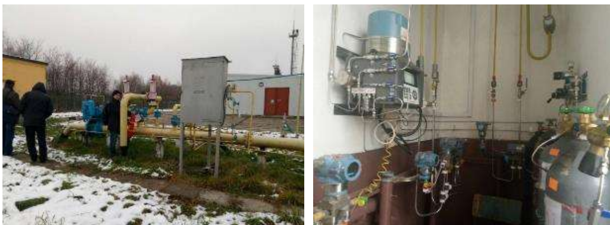
Рисунок 5.1 - Відбір проби на ГРС Угринів та використання потокового хроматографа Danaluxer 370 ХА
