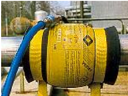
Ліквідація витоку НХР шляхом встановлення на пошкоджену ємність пневмобандажу (А та Б) або встановлення пневмоклину (В)
