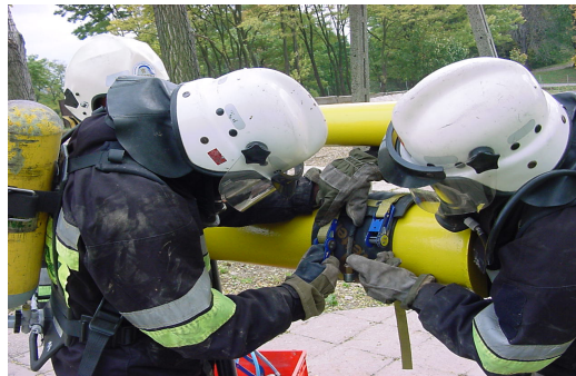
Ліквідація витоку НХР шляхом накладання аварійного хомута на пошкоджений трубопровід
